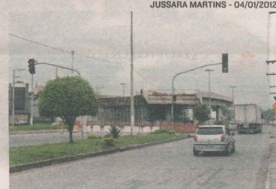
TRECHO da BR-262 próximo à Ceasa
