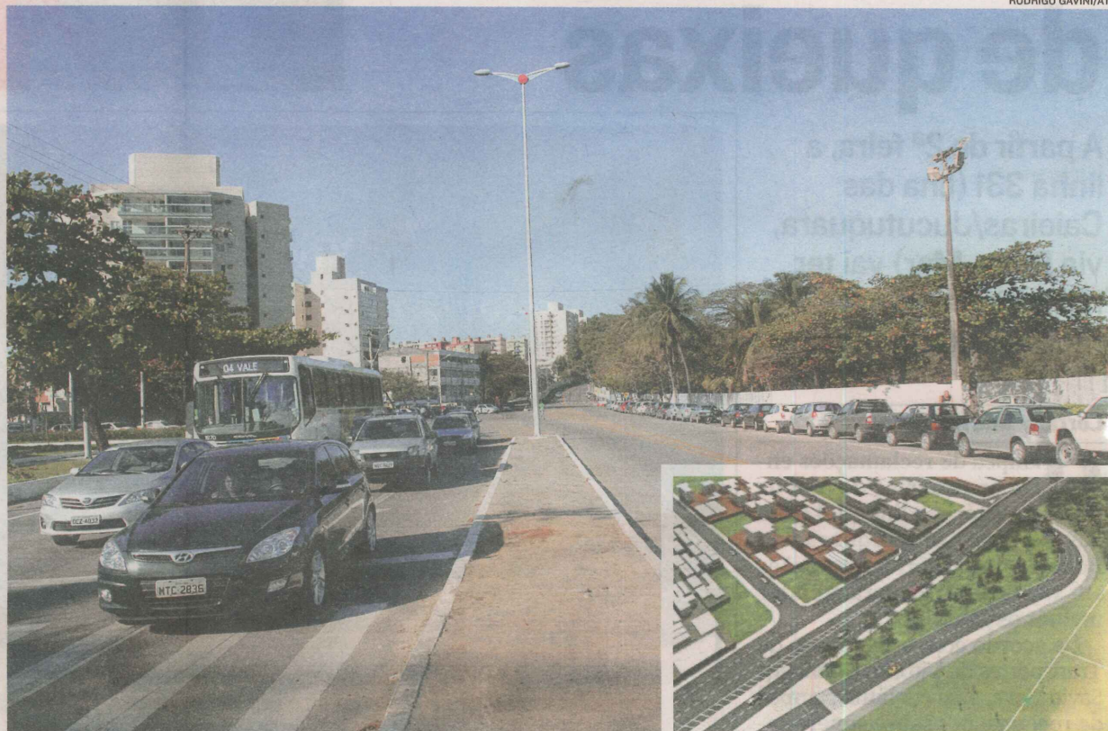
FINAL da avenida Dante Michelini, onde viaduto está sendo construído. Objetivo da obra é melhorar acesso à região
