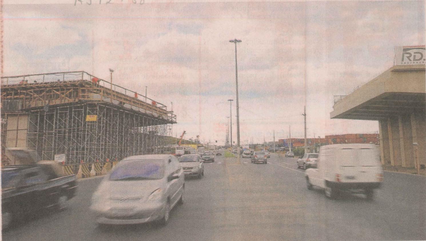
**ANDAMENTO.** Três dos nove vãos de vigas metálicas de um sentido da estrutura e o primeiro vão no lado contrário estão prontos
