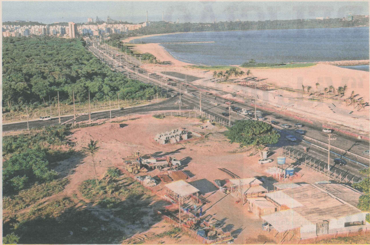
CANTEIRO DE OBRAS em área na praia de Camburi onde ficará o centro de eventos do novo aeroporto de Vitória
