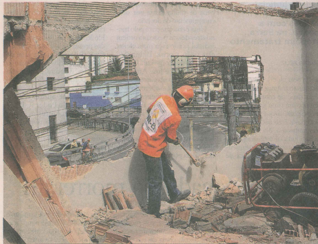
NOVO DESENHO. Cinco casas foram demolidas até ontem para dar lugar à nova alça
