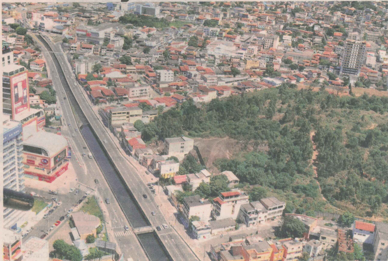
VISTA AÉREA do trecho em Vila Velha por onde viaduto vai passar. À direita, Morro do Marista, área alvo de disputa
