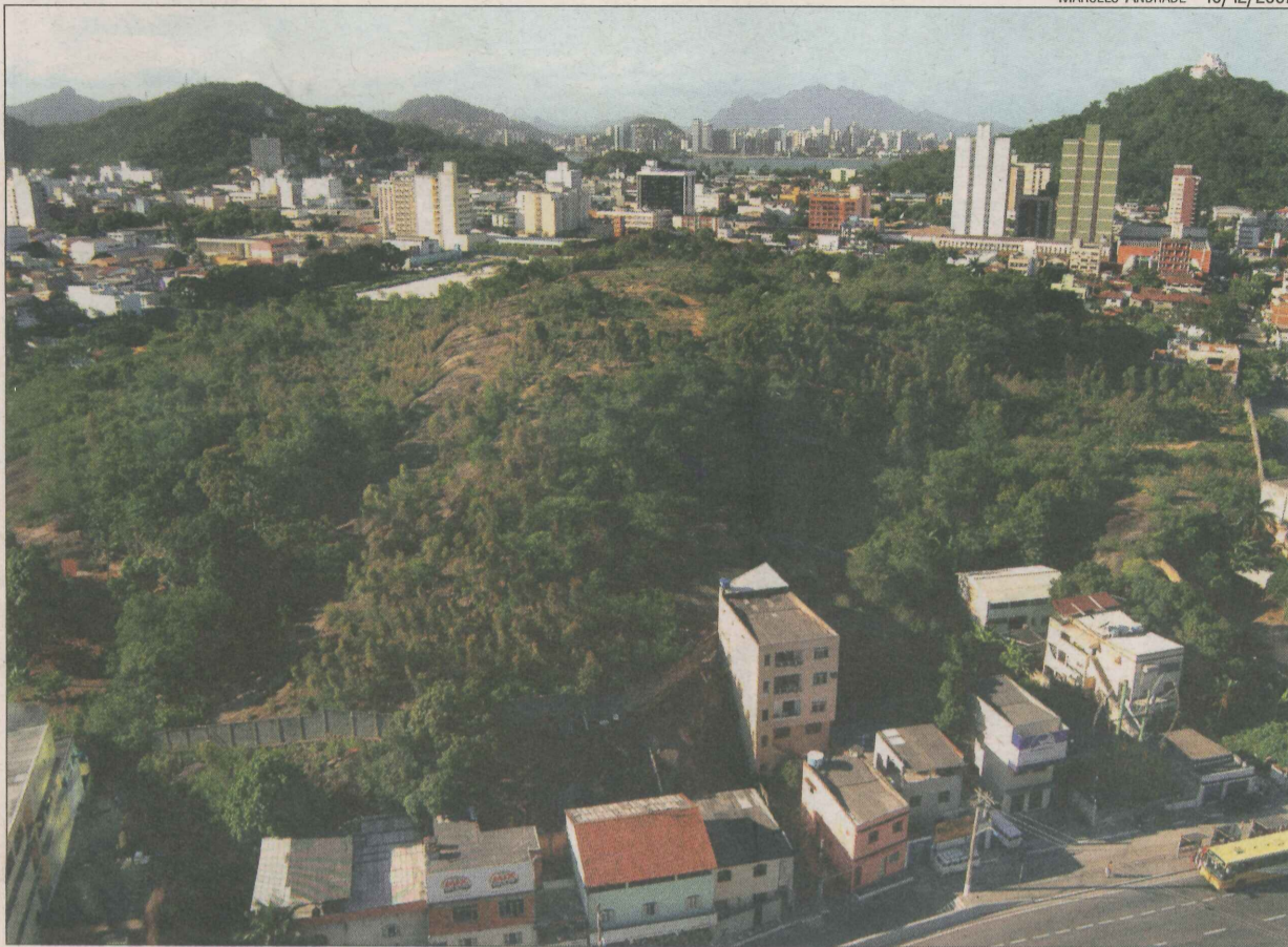
Morro do Marista, área onde vai ser construída a alça da Terceira Ponte, em Vila Velha
