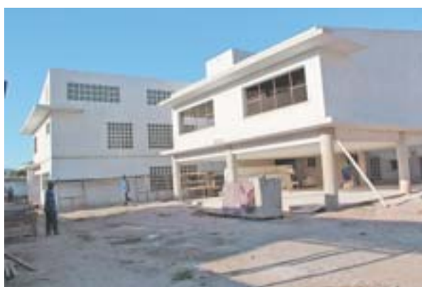
OBRAS NA UMEI DE RIO MARINHO já estão em fase de conclusão
