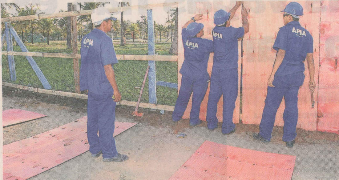
TAPUMES. O canteiro de obras no Tancredão está sendo montado. Obras vão custar R$ 26 milhões
