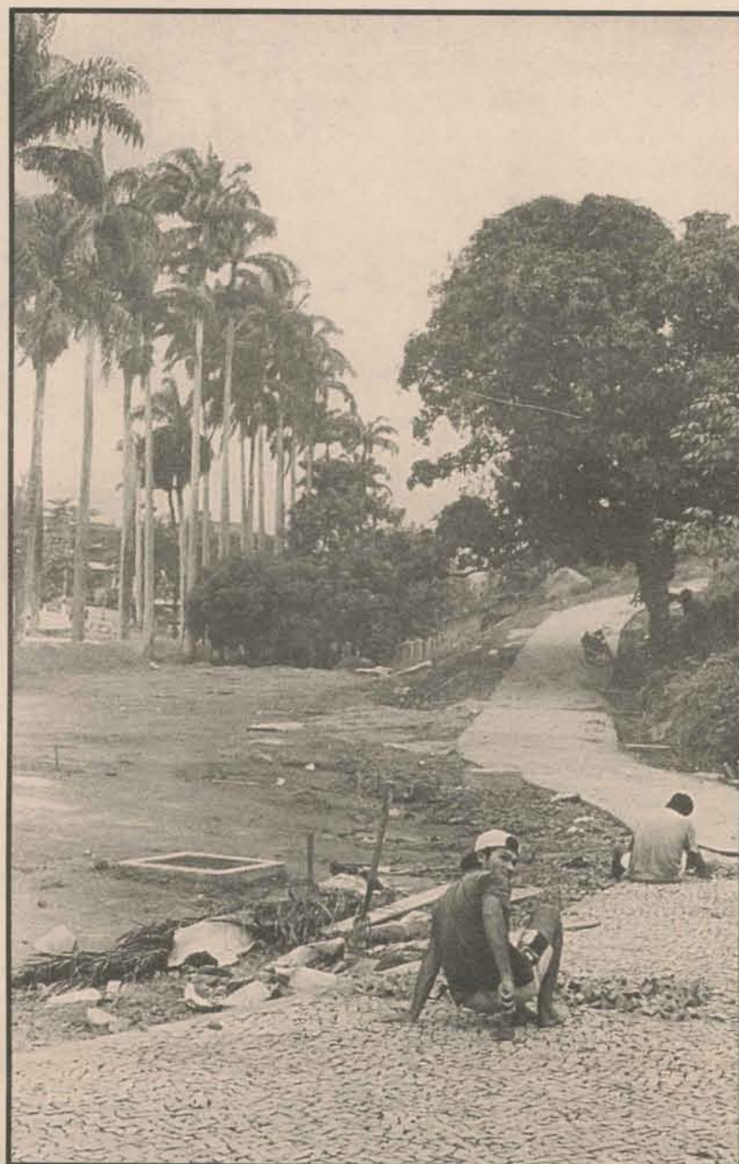
Obras para a reabertura do Horto começaram em 1993
