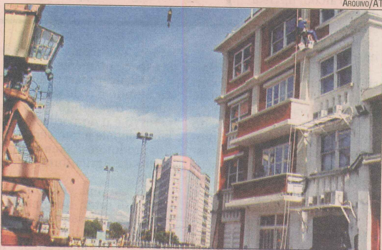
A pintura externa dos prédios começou nesta semana
