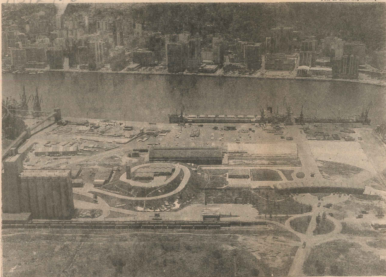
Codesa está investindo Cr$ 6 bilhões para ampliarem 80% capacidade de armazenagem instalada em Capuaba
