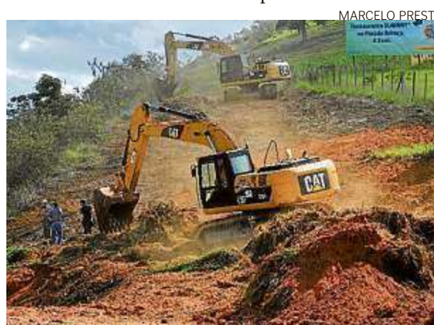
Canteiro de obras foi aberto ontem em Ibirapu
