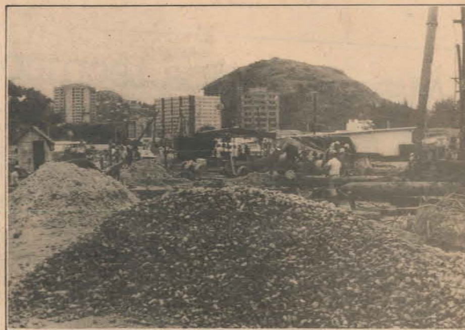
Obra teve três canteiros
