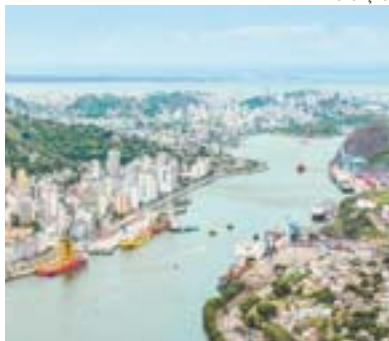
PORTO DE VITÓRIA: obras
