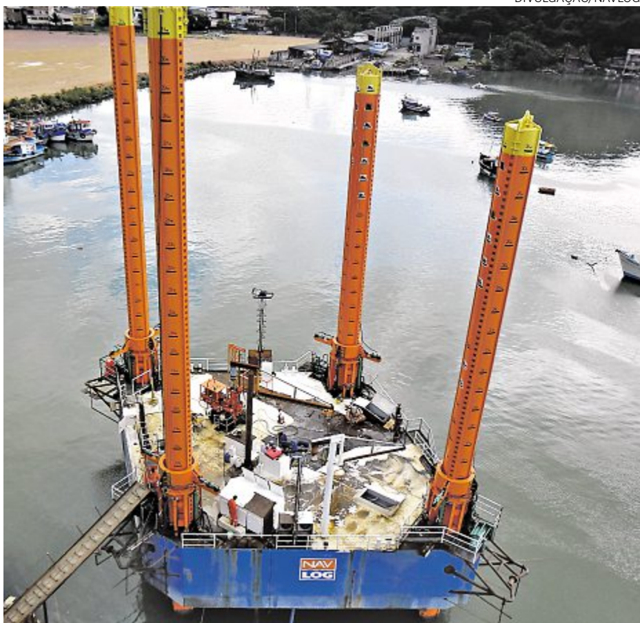
Equipamento Nav I foi totalmente executado na Enseada de Jaburuna, Glória
