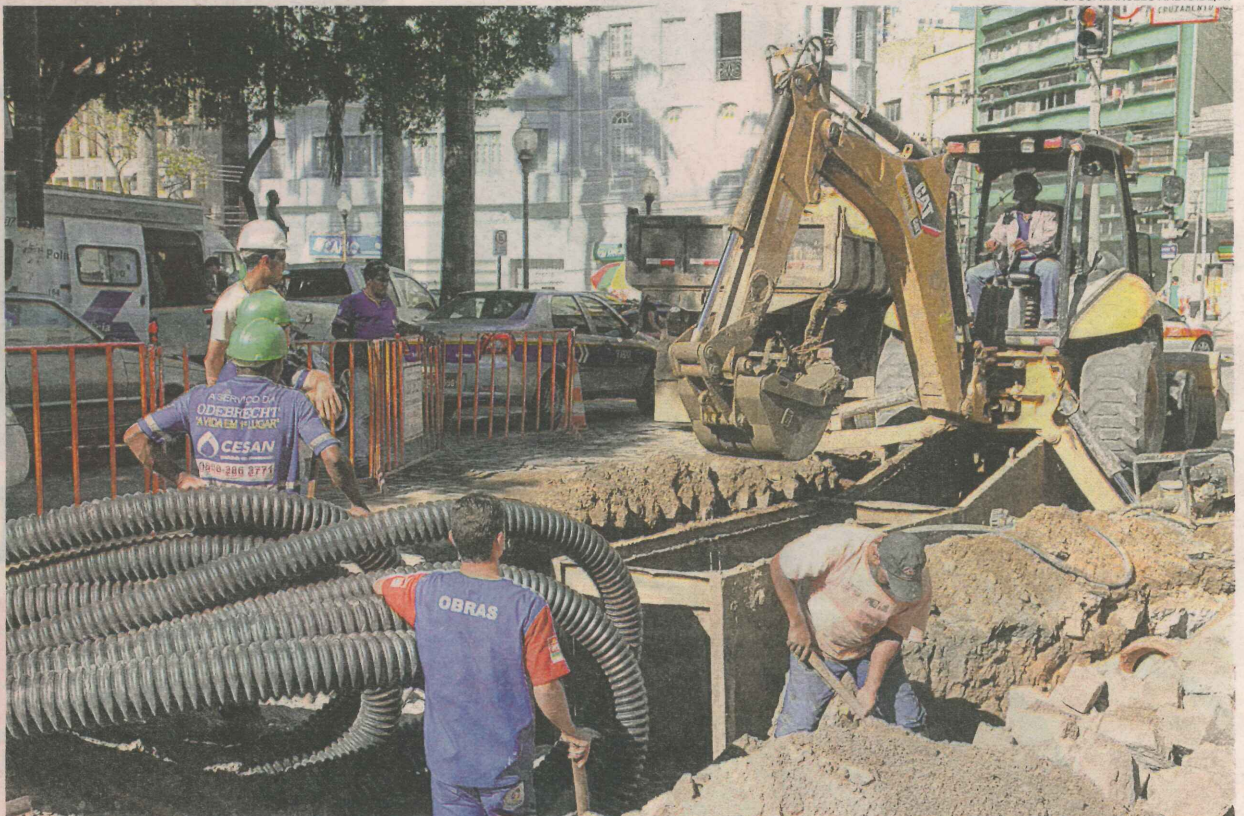
A CESAN está fazendo obras na rede de esgoto, enquanto prefeitura instala tubos para passagem de fiação elétrica
