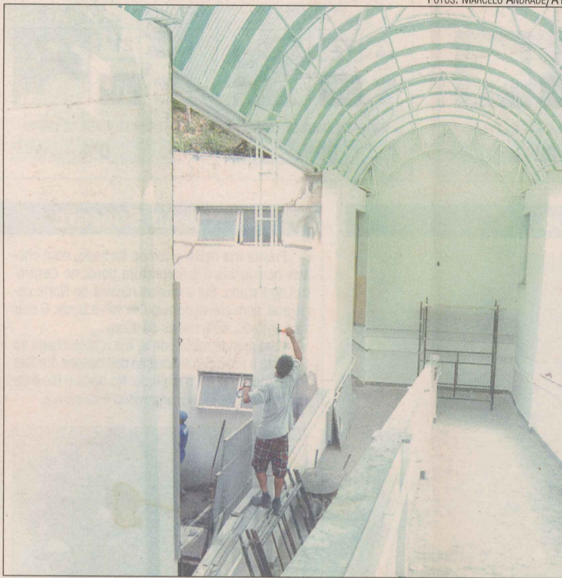
O Pronto-Atendimento de Itacibá está passando por reformas
