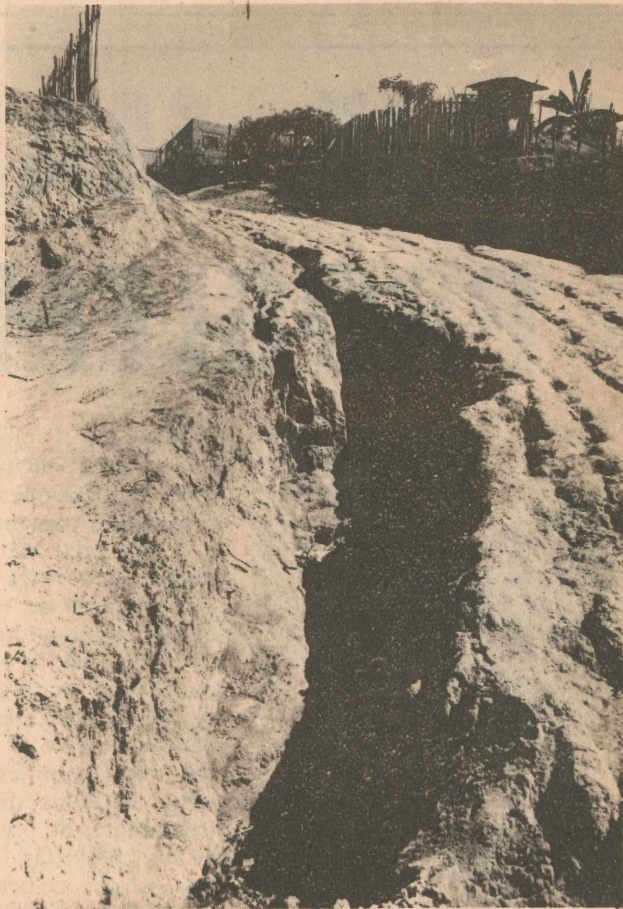
Não existe qualquer infra-estrutura
