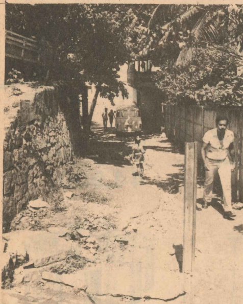
A rede de esgotos é um dos problemas
