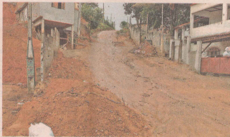
PROBLEMA. A chuva deixa as principais vias de acesso ao bairro interditadas por causa da lama. FOTO: GABRIEL LORDÉLLO
