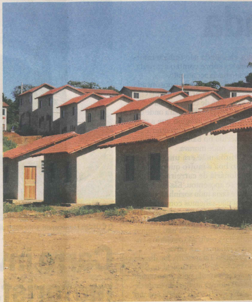
ESTE CONJUNTO teve obras interrompidas por causa de material rochoso
