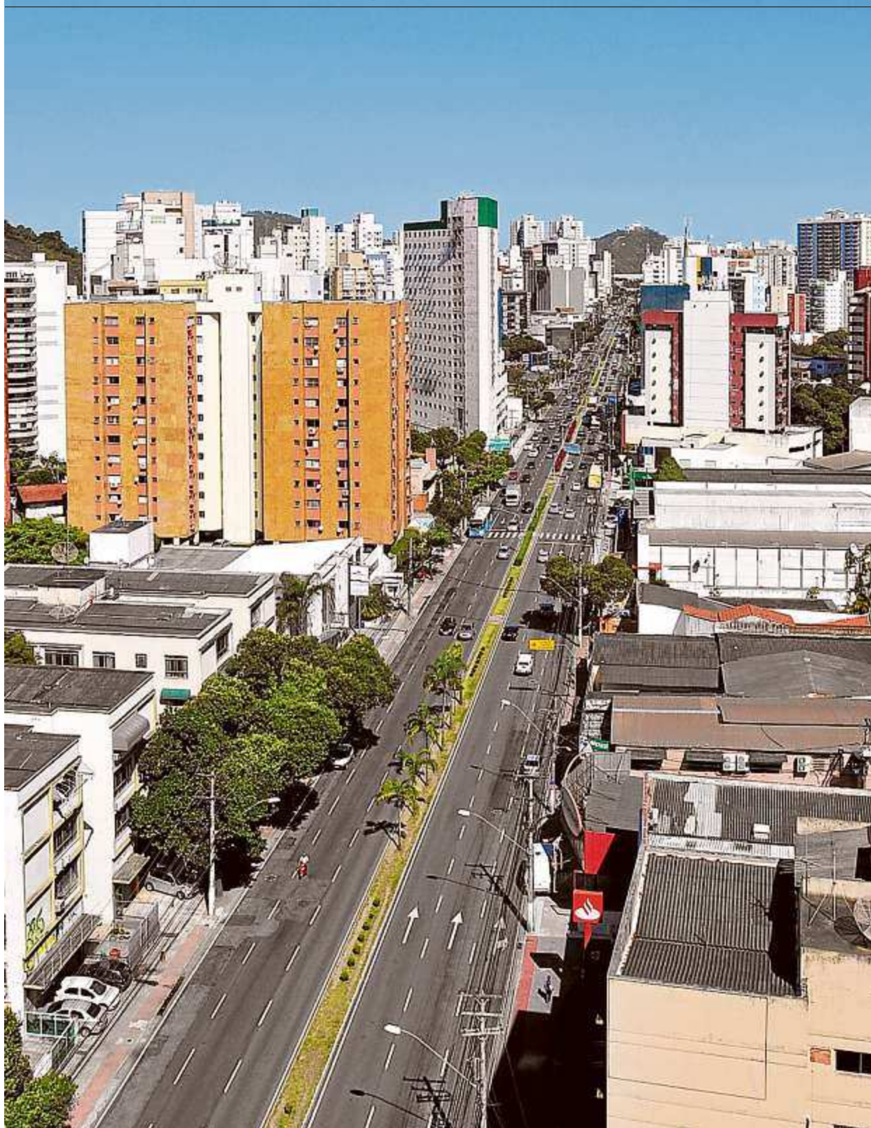
A Avenida Nossa Senhora da Penha é ocupada por vendedores autônomos e por grandes empreendimentos
