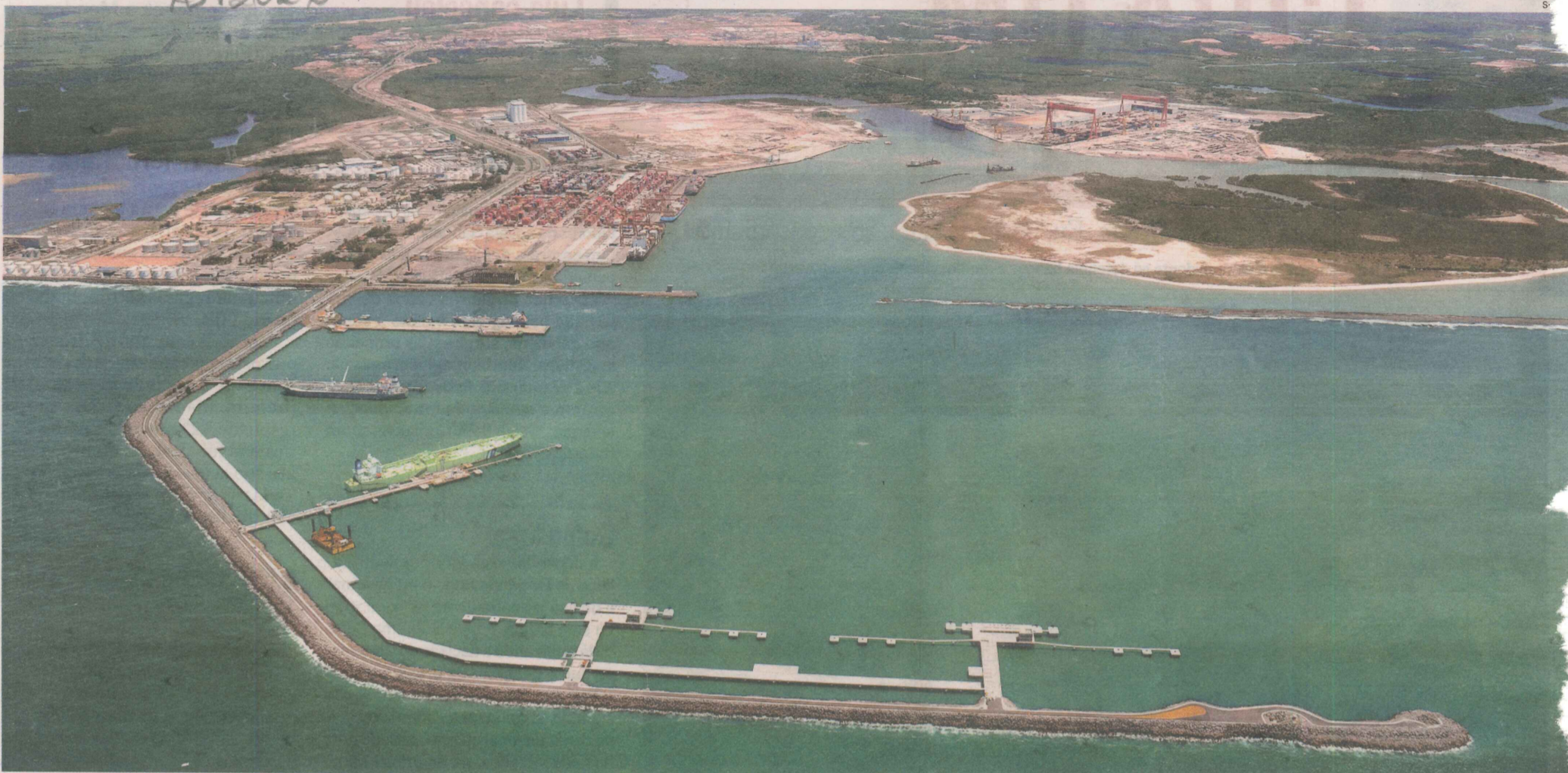
PORTO DE SUAPE: o terminal de águas profundas a ser implantado vai seguir o modelo do empreendimento em operação em Pernambuco. Investimento inicial está estimado em R$ 2,6 bilhões
