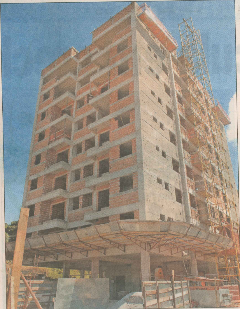
As obras do Residencial São Geraldo estão em andamento
