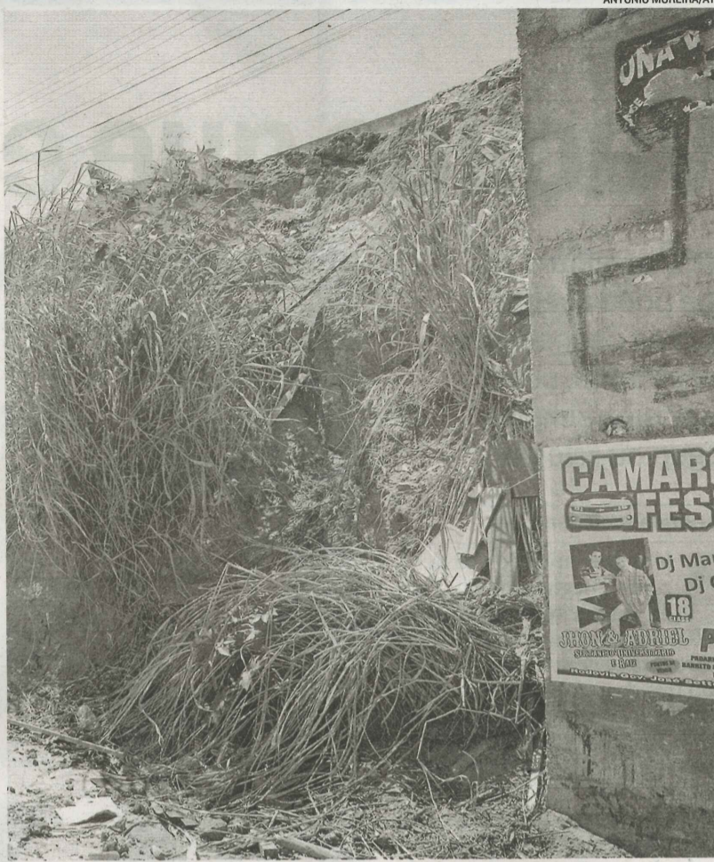
OBRA NO MURO vai conter o deslizamento de terra em períodos de chuva
