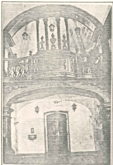
O revestimento interno das paredes também precisa de muitos reparos
