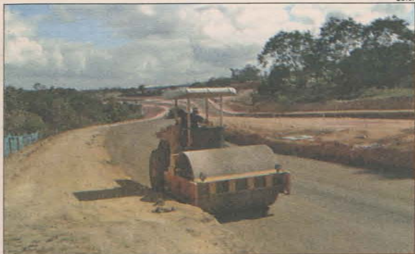
Obras e mais empreendimentos na construção civil
