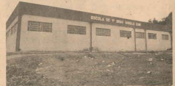
A escola Angelo Zani possui seis salas de aulas e foi uma das beneficiadas pela Secretaria de Educação do município
