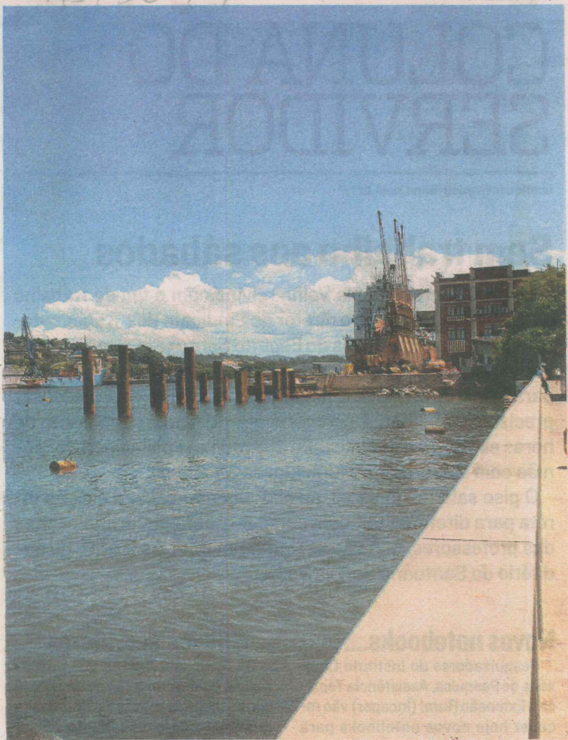
VIGAS que darão sustentação à base do Cais Comercial de Vitória
