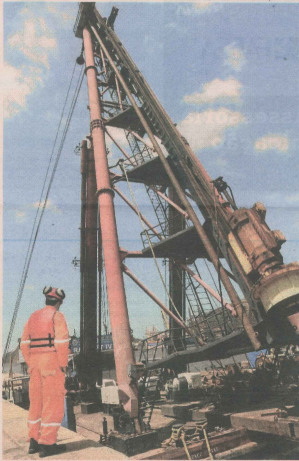
Máquinas que vão operar durante intervenções
