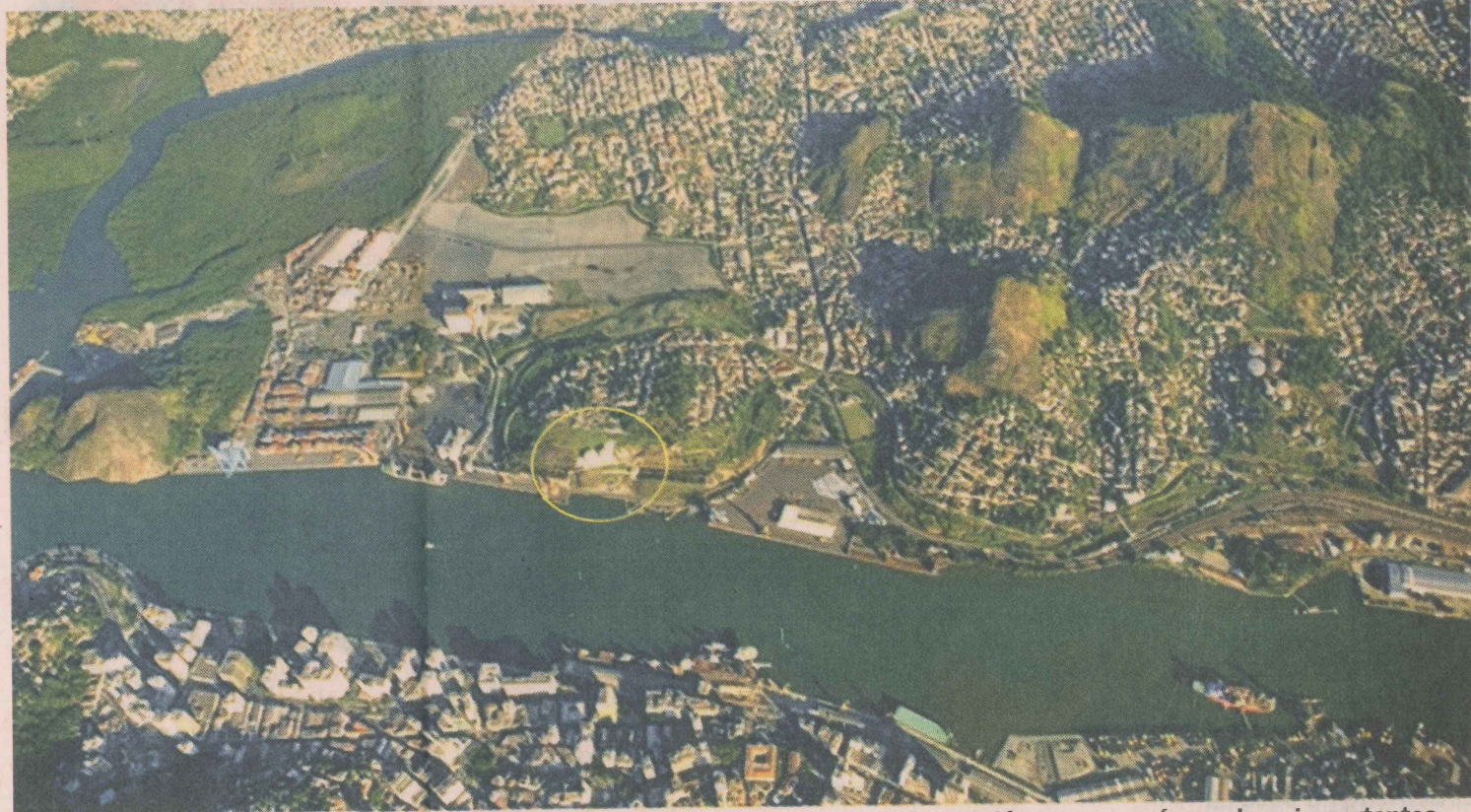
DESENVOLVIMENTO. Na área circulada acima, está o Cais do Atalaia, entre Capuaba e Peiú, que passará por obras importantes
