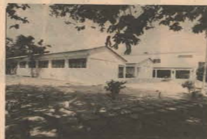
Os três pavilhões construídos pela Funcab em Colatina
