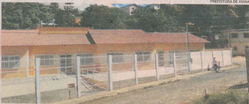
CRECHE NO BAIRRO INDUSTRIAL, em Viana, foi entregue recentemente
