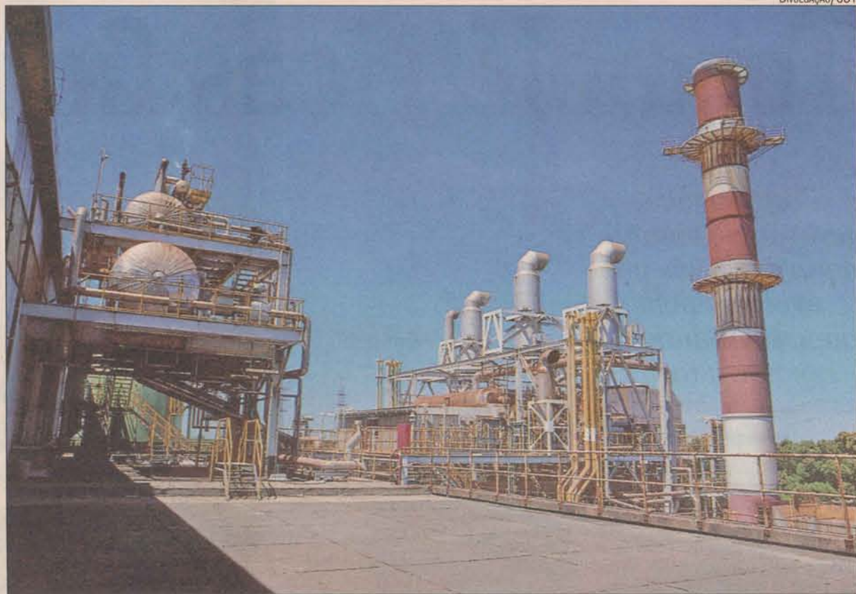
A CST produz energia a partir do aproveitamento dos gases resultantes do processo industrial
