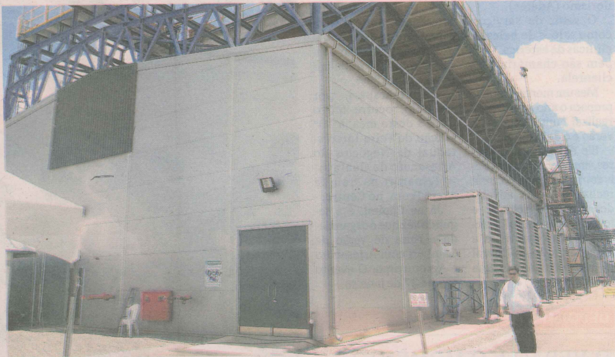
Usina termelétrica de Linhares, uma das que foram acionadas pelo ONS para suprir deficiência energética
