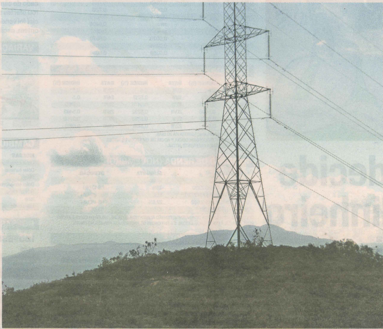
TORRE DE ENERGIA: o Espírito Santo vai ganhar, além de duas subestações, mais três linhas de transmissão
