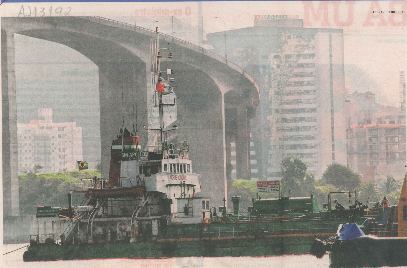
A EMBARCAÇÃO encalhou em banco de areia formado devido ao acúmulo de sedimentos no cinturão de pedras que protege o pilar da Terceira Ponte
