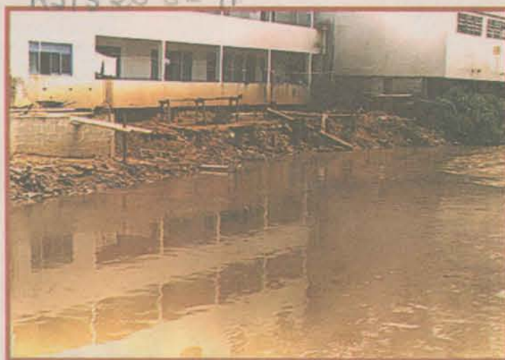
Em Marechal o esgoto é lançado in natura no Rio Braço Sul e a prefeitura diz que não tem verba para resolver o problema
