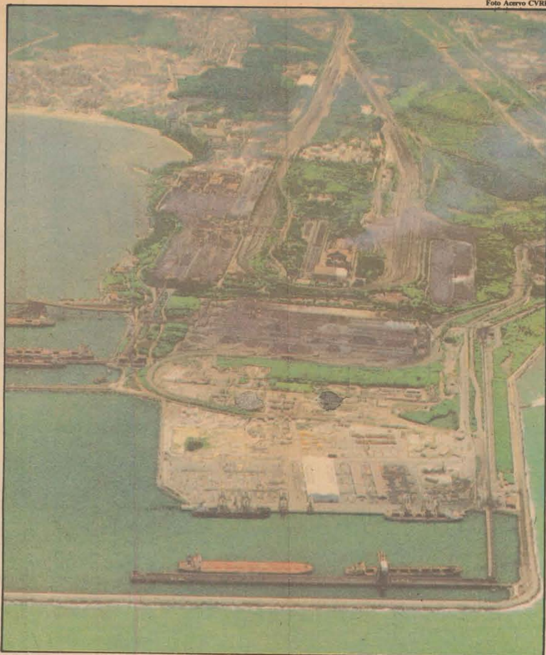
Vista aérea da Ponta de Tubarão. Nesta região, no passado fazenda de gado, começou a grande virada
