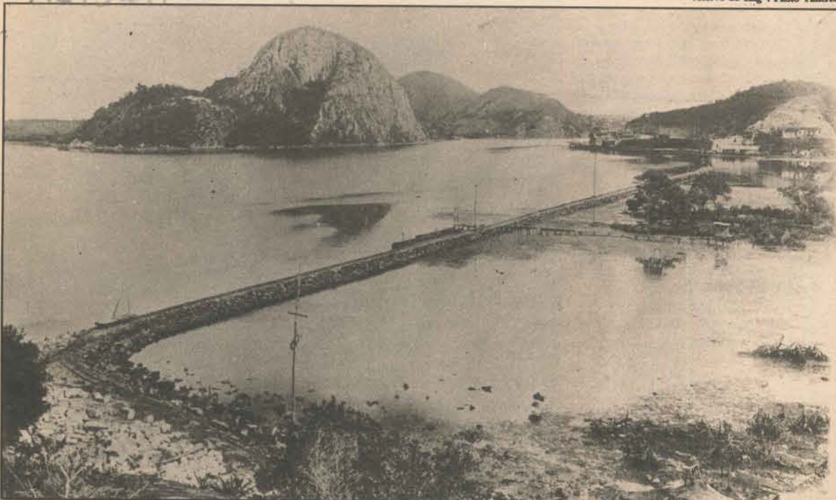
Na década de 20, o crescimento urbano de Vitória exigiu imensos aterros, como este da Avenida Beira-Mar
