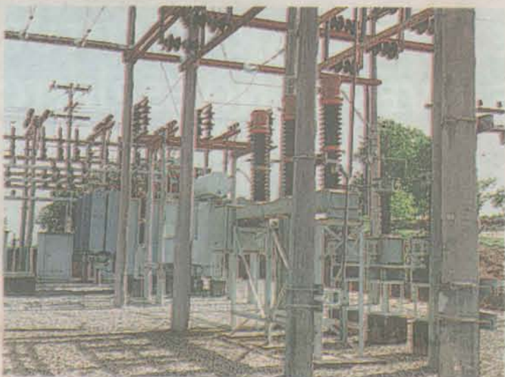
Vista da barragem de Santa Maria, no alto, e a subestação de Colatina, acima
