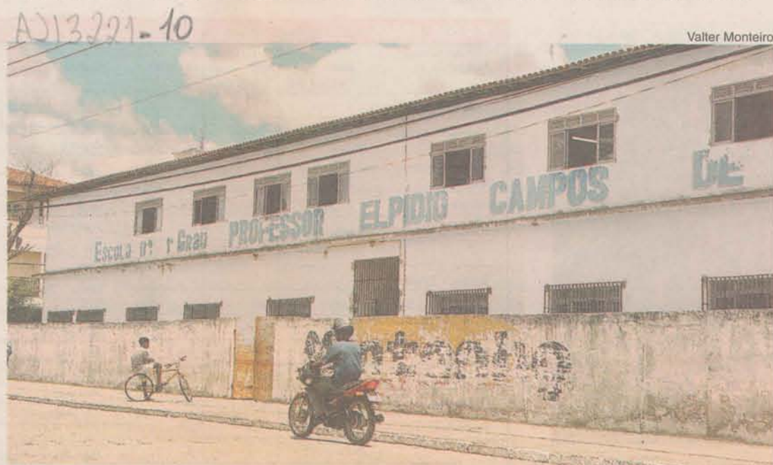
A Prefeitura de Montanha fez obras de reforma total em cinco escolas da rede municipal, que já foram entregues à população, beneficiando, aproximadamente, 500 pessoas
