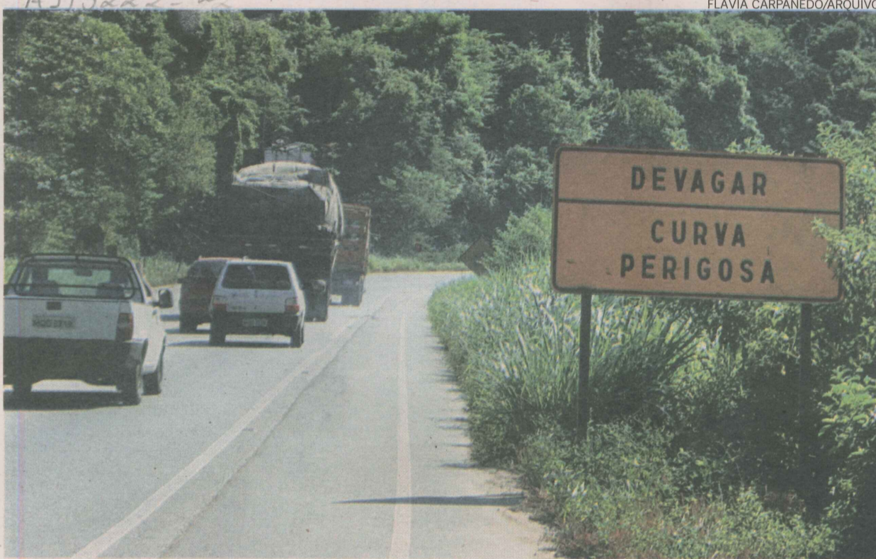
A extensa BR 101 é uma via de escoamento da produção industrial do Espírito Santo: à espera pela duplicação
