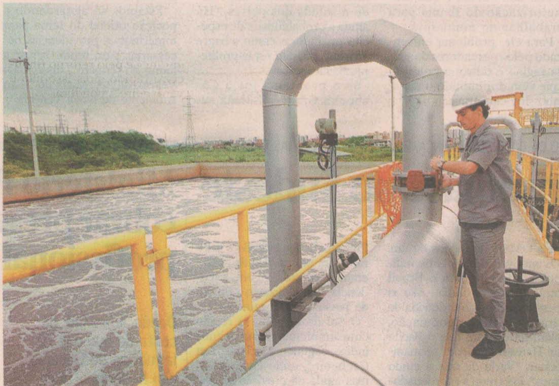
ÁGUA. Cesan está investindo R$ 20 milhões na ampliação de estações de tratamento. FOTO: DIVULGAÇÃO
