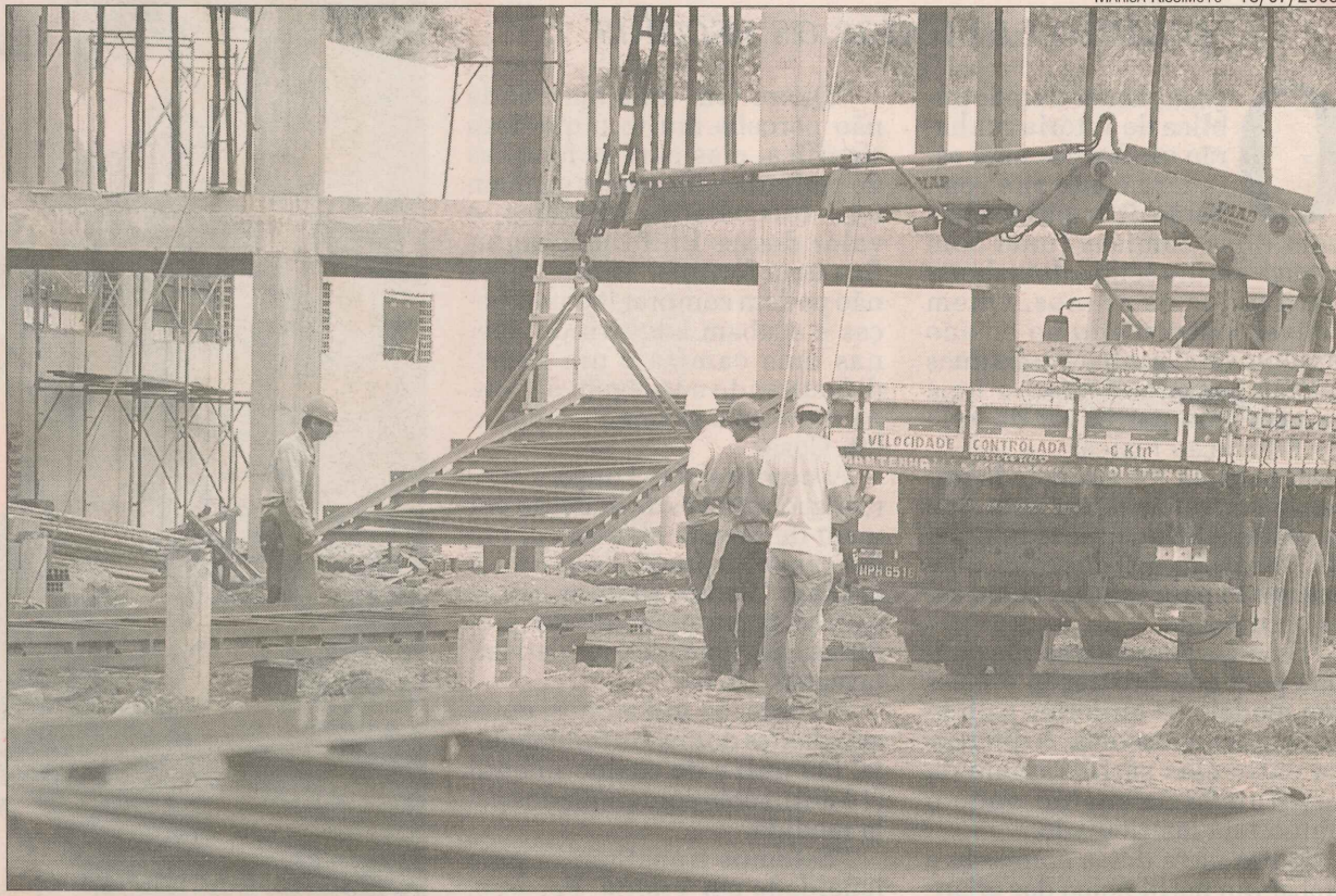
A área de construção civil está incluída entre os cursos que vão ser oferecidos
