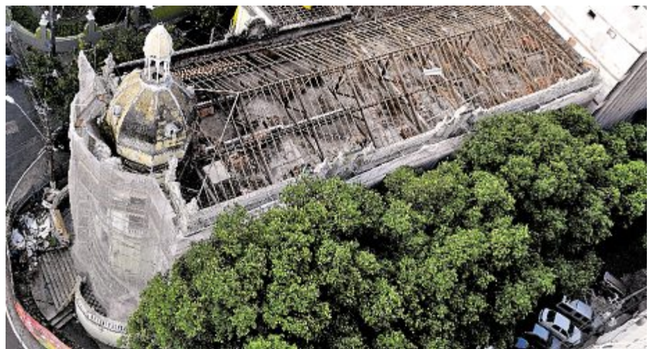
A previsão é de que a reforma seja completamente concluída até junho de 2014
