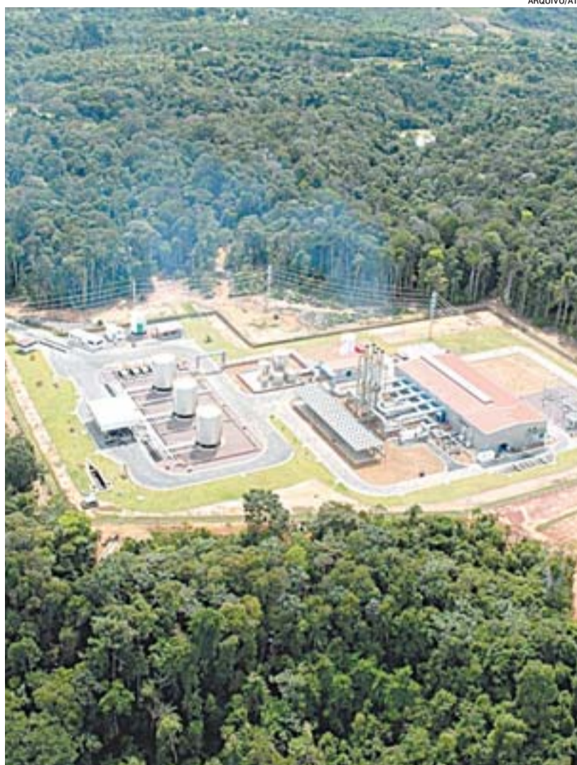
USINA TERMELETRICA produz energia mais cara do que a hidrelétrica
