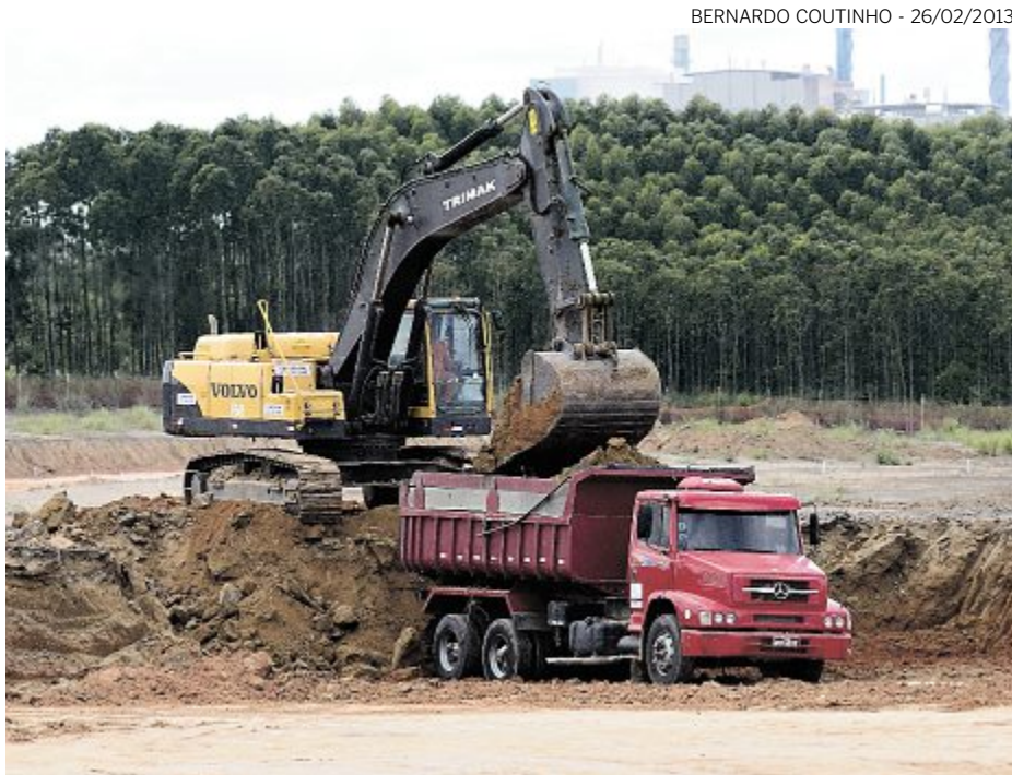
Área que vai abrigar o estaleiro da Jurong em Aracruz já recebe intervenções
