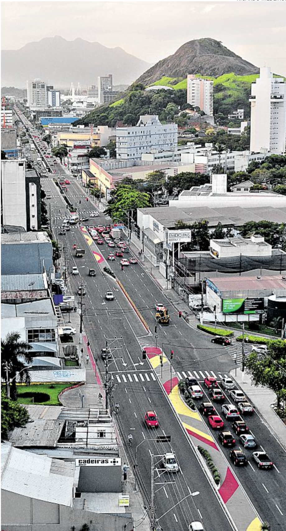
A avenida terá ciclovia no canteiro central e três faixas em toda sua extensão
