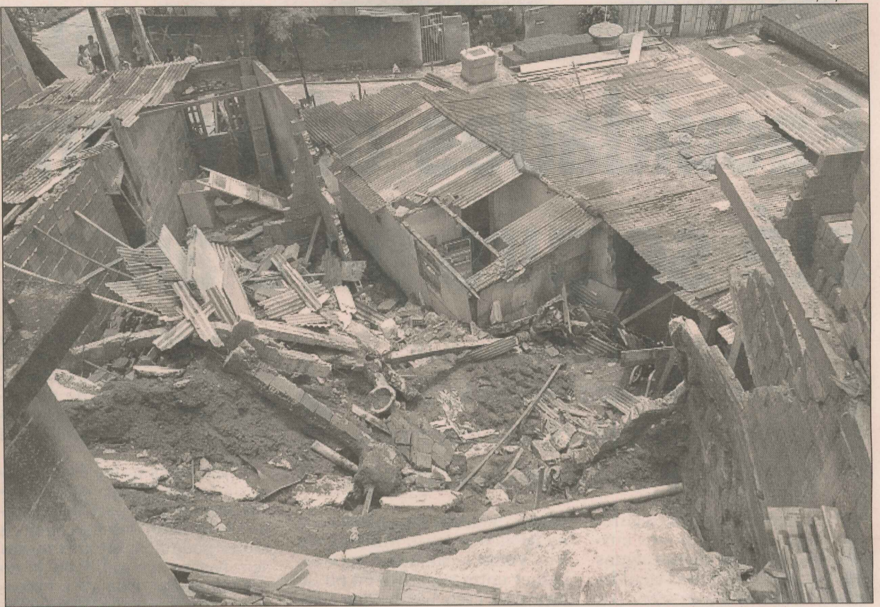
Desabamento de casa em encosta de Vila Velha: risco aumenta em período de chuva
